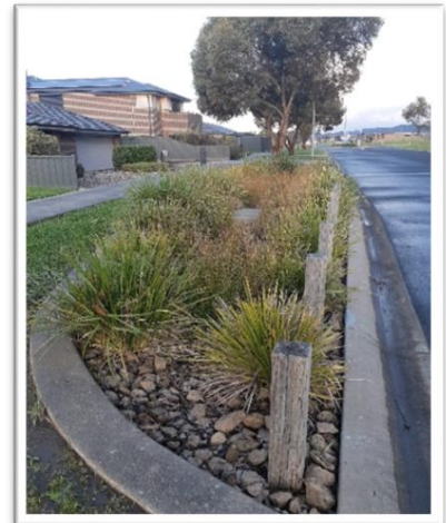
Rainwater Garden in Elliminyt
